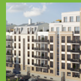
»inno« 63 Haus- und Gebäudetechnik
